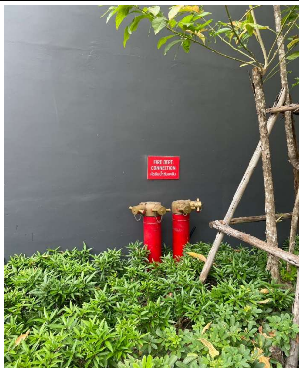
ภาคผนวกที่ 3.51 ตรวจสอบหัวรับน้ำดับเพลิง ด้านหน้าโครงการ
